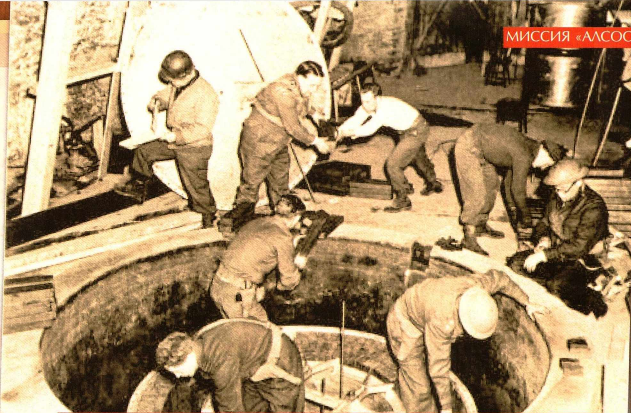
Британские и американские члены миссии «Алсос» демонтируют экспериментальный ядерный реактор, построенный немецкими учеными в рамках немецкого проекта ядерной энергетики в Хайгерлохе
